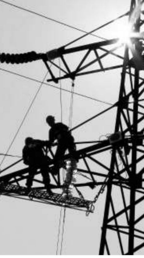
Работники на вышке ЛЭП.
