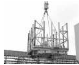
На НВАЭС начали устанавливать ключевой кран для перегрузки топлива
