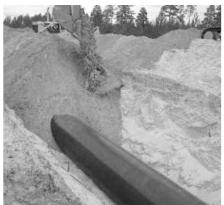
Прокладка волоконно-оптического датчика СОУИКА на трубопроводе «Пур-Пе — Самотлор»
