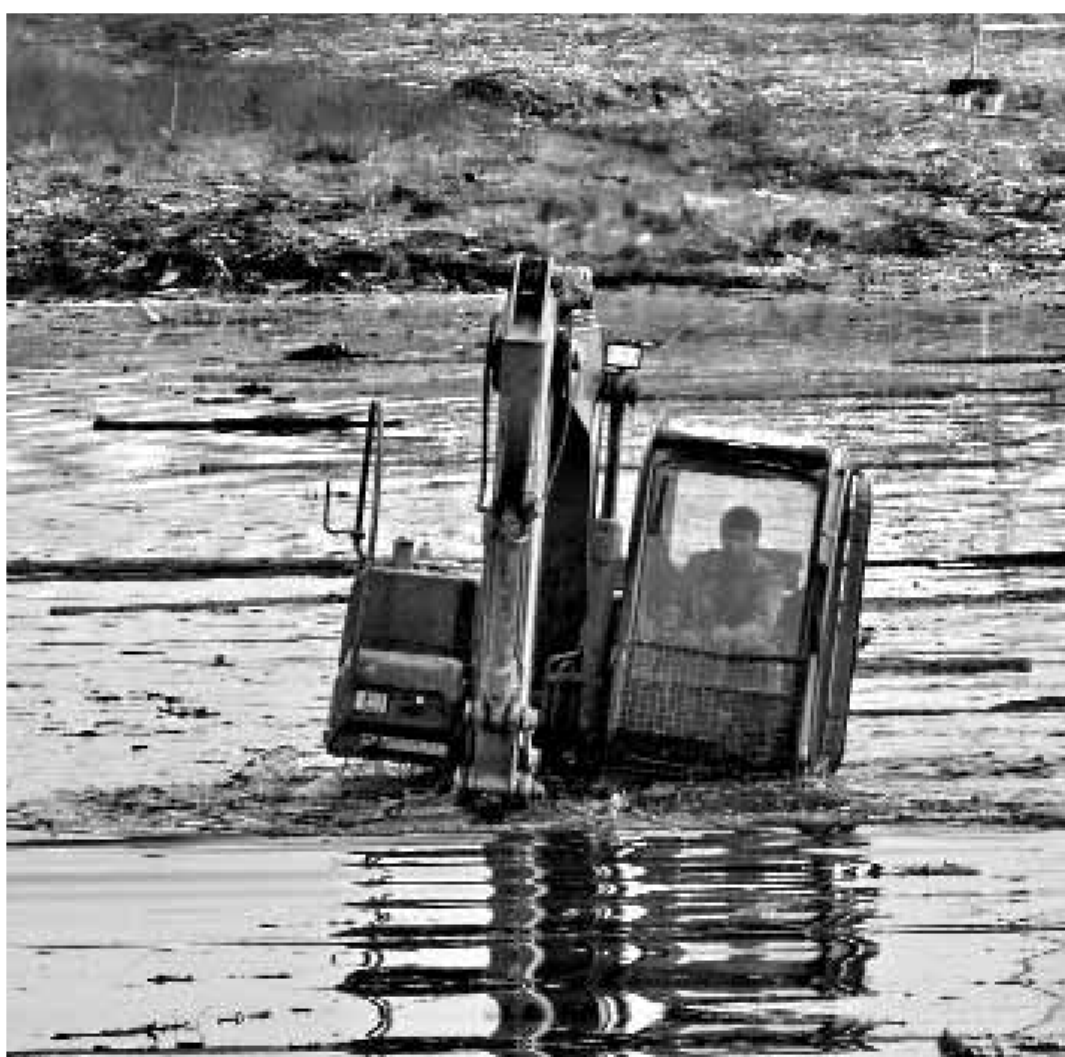
Условия строительства электросетей бывают самыми экстремальными
