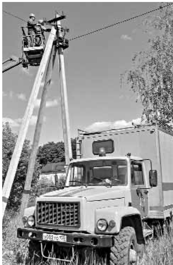
Только в одном Люберецком районе Подмосковья, наиболее пострадавшем от «ледяного дождя», Московская областная энергосетевая компания в этом году заменила на СИП более 30 км воздушных линий электропередачи
