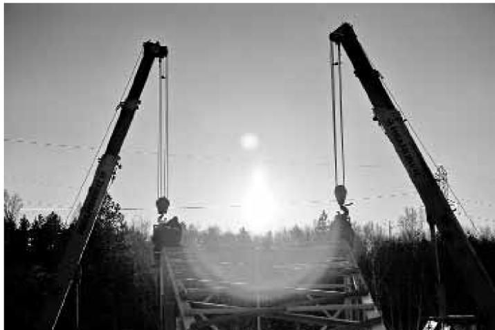
нии ВЛ 500 кВ «Зейская ГЭС — Амурская» с суходоходной рекой Зей «Индастек» выполнит строительство спешерехода, длина которого составит 2275 м, высота опор — 99 м. Поскольку температура воздуха в зимний период на этом участке может достигать 52 градусов мороза, провод, изоляция и арматура на переходе будут исполнены в усиленном варианте. Завершение всех строи-
