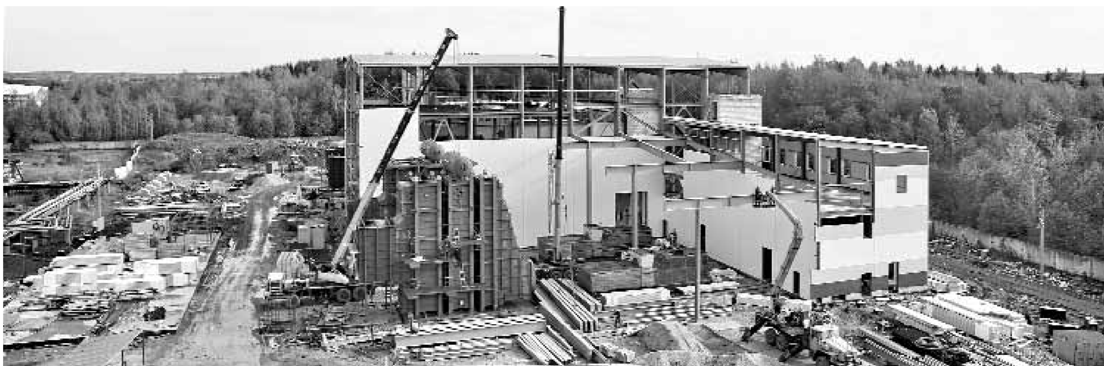
Строительство ПГУ-ТЭС-52 в г. Тугаеве
