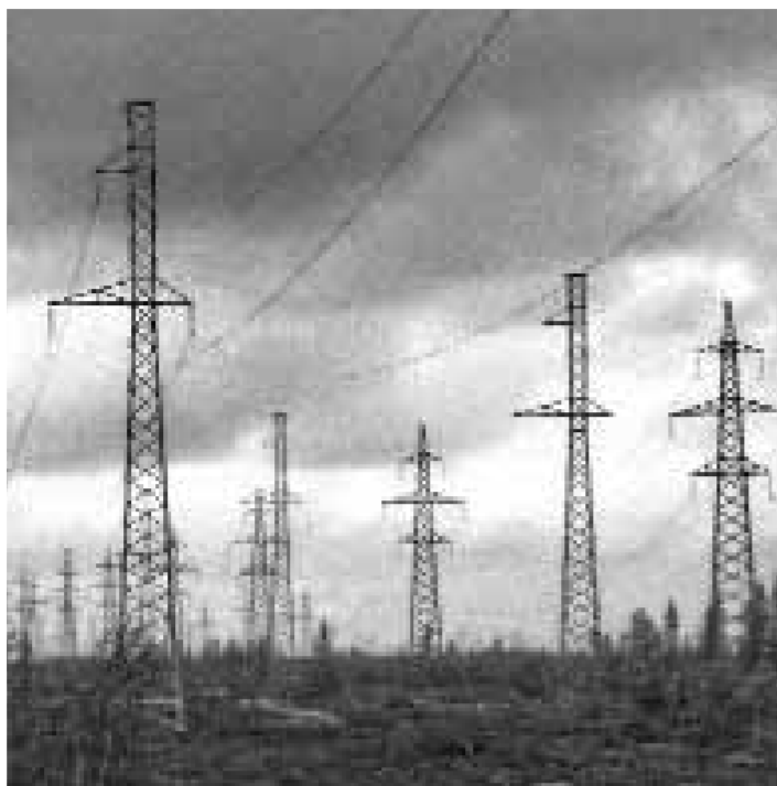
т.г. введения в эксплуатацию нового энергоблока на Уренгойской ГРЭС. В состав работ по строительству ВЛ-110 кВ Уренгой — УГРЭС входит: сооружение двух одноцепных
