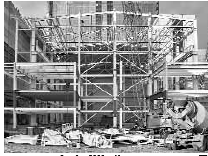
Октябрь 2008 г. Монтаж каркаса корпуса ГТУ
