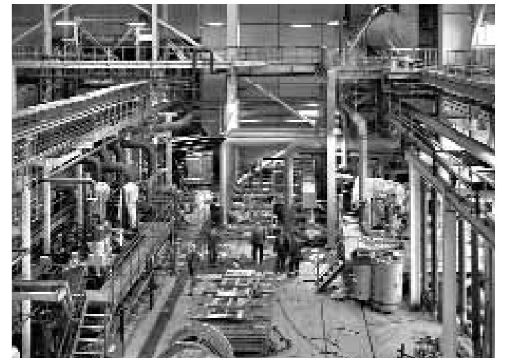
Январь 2010 г. монтаж оборудования в здании гл. корпуса
