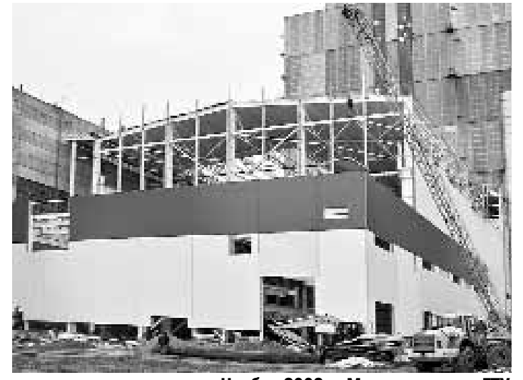
Ноябрь 2008 г. Монтаж корпуса ГТУ
